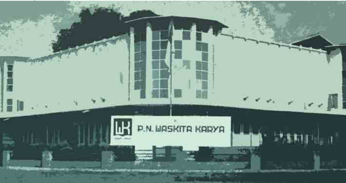
Gedung Lama Kantor PT Waskita Karya (Persero) Tbk / Old Office of PT Waskita Karya (Persero) Tbk
