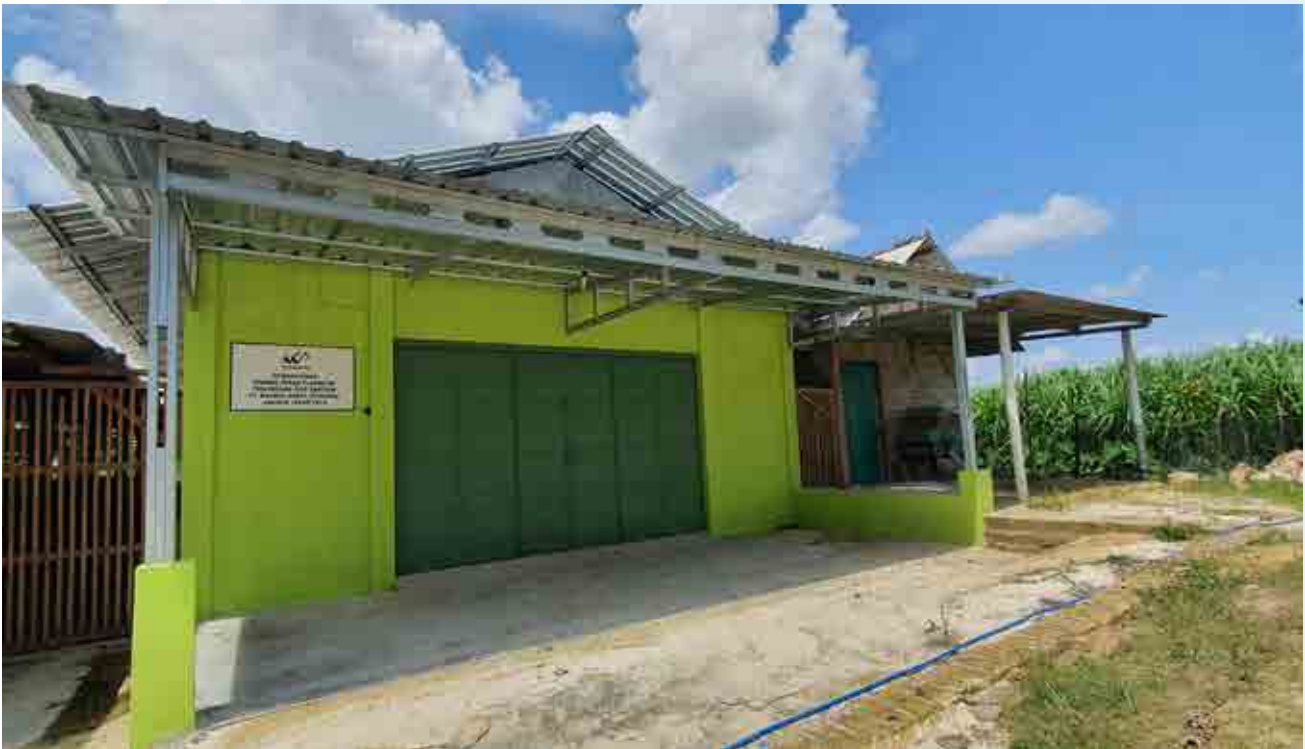
Bantuan PKBL untuk pembangunan gudang pakan ternak di Blora / SME & CSR assistance for development of animal feed warehouse in Blora
