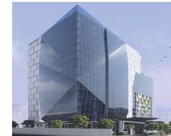
Waskita Rajawali Tower, Jakarta
