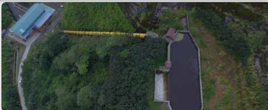
Pembangkit Listrik Mini Hidro 2 x 5 MW / Minihidro Power Plant 2 x 5 MW
