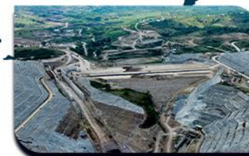
Swasembada Air Bendungan Mbay
