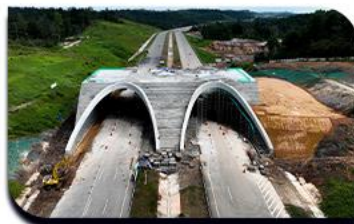
Kawasan Pembangunan Ibu Kota Nusantara (IKN) Jalan Tol IKN seksi 3B
