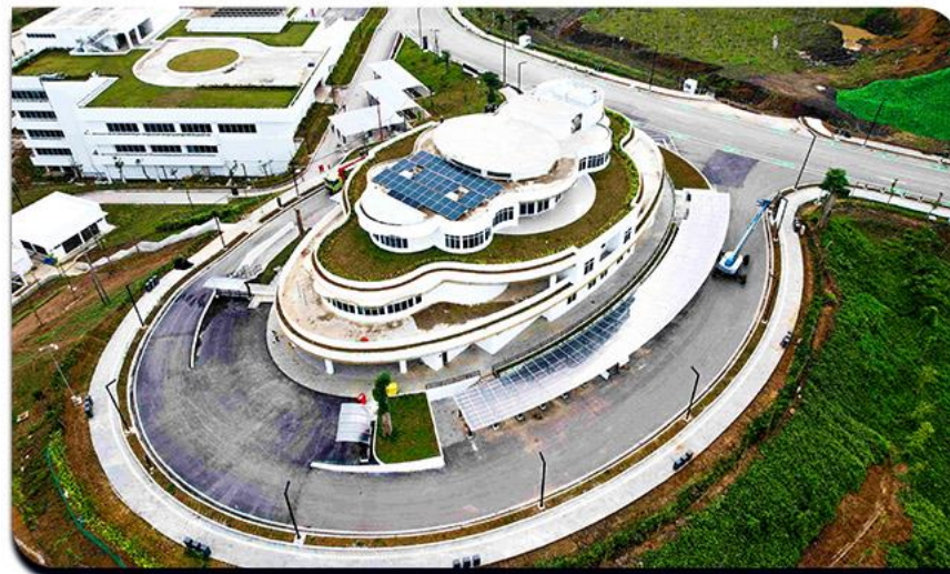
Gedung Sekretariat Presiden dan Bangunan Pendukung
